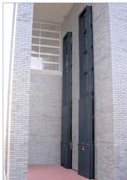
Figure 4. Plateforme monte-charges à double colonne de guidage EH/DCL.
